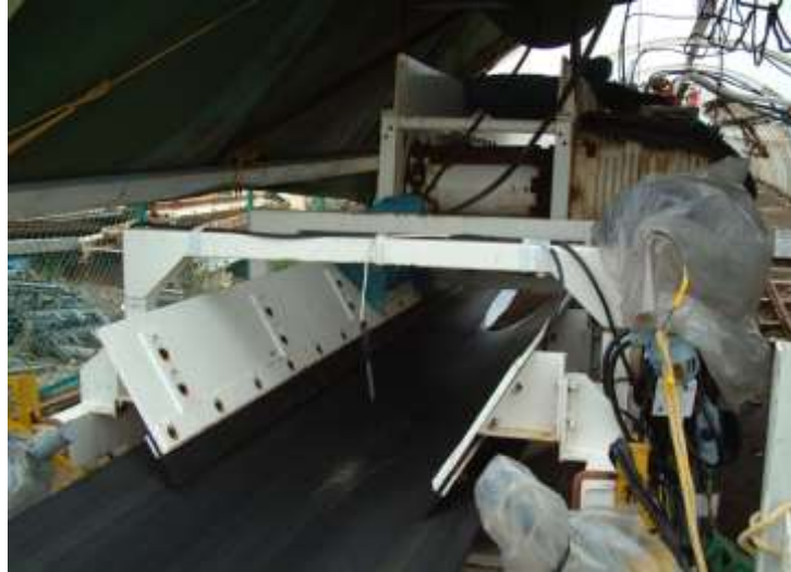
Gambar 10 Detektor Penumpukan Chute
