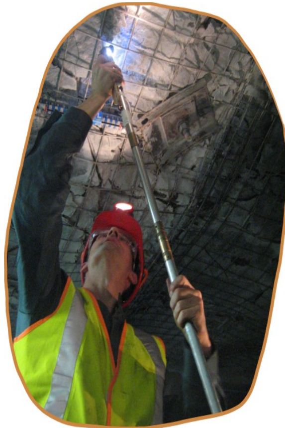
Gambar 4. Cara Memasukkan Alat Pada Lubang Bor
