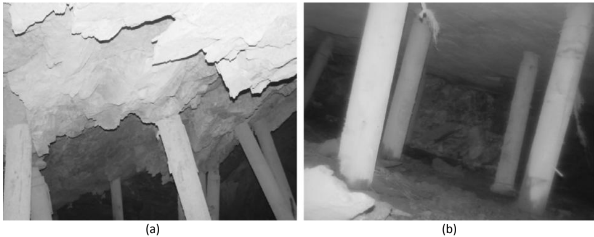
Gambar 1. Perbandingan Kondisi Hanging wall setelah peledakan a). menggunakan bahan peledak jenis powder dengan pengisian yang berlebihan/melimpah b). menggunakan bahan peledak jenis cartridge
